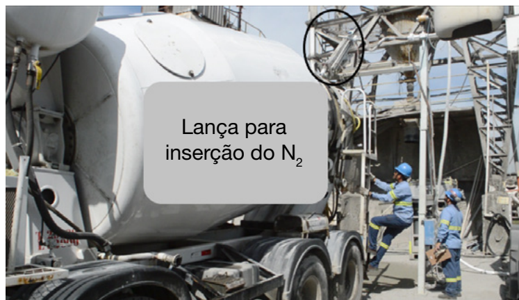
Figura 8.6 – Início de operação. Notar lança para inserção do N_2 no caminhão-betoneira. Fonte: Desek.
