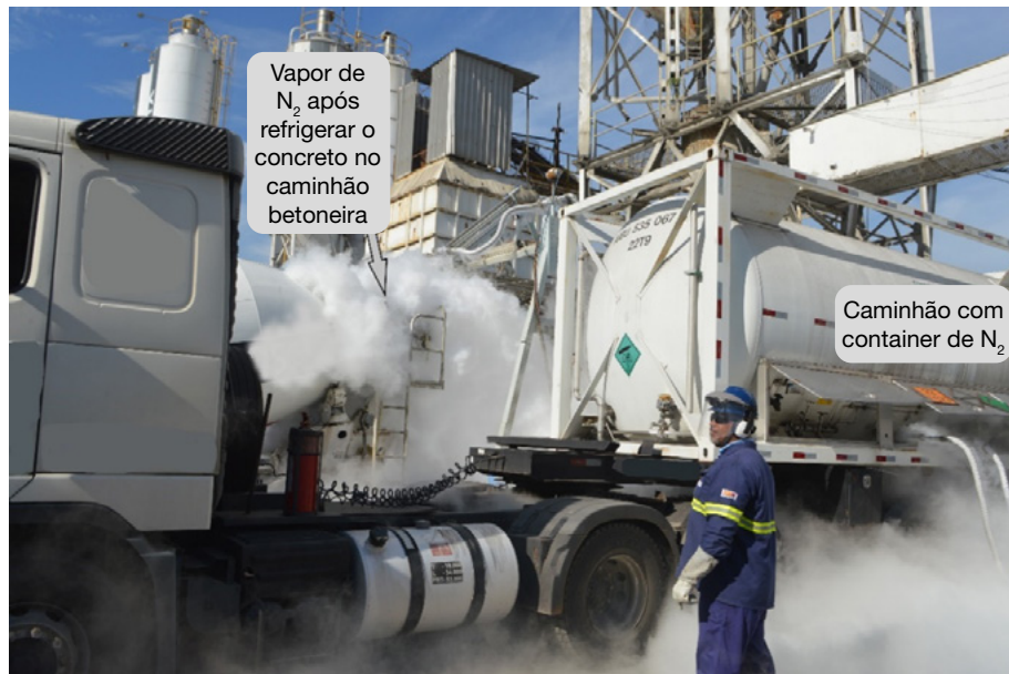
Figura 8.7 – Operação de refrigeração em andamento. Notar vapor de N_2 . Fonte: Deseq.
