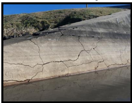
(a) Parede do dique de uma barragem.
