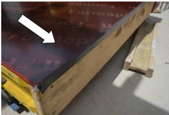
Figura 12 – Exemplos de vedação das regiões inferiores das fôrmas para paredes de concreto com materiais flexíveis (Arquivo Deseq, 2022)
