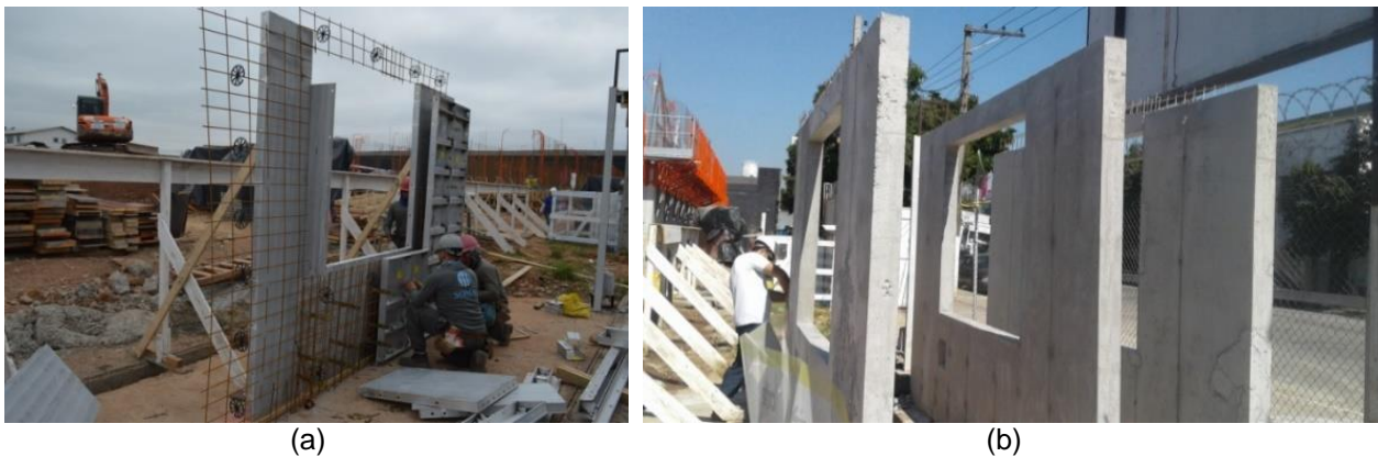
Figura 20 – Protótipos de paredes de concreto em (a) fase de instalação das fôrmas e (b) após execuções (Arquivo Deseq, 2021)
