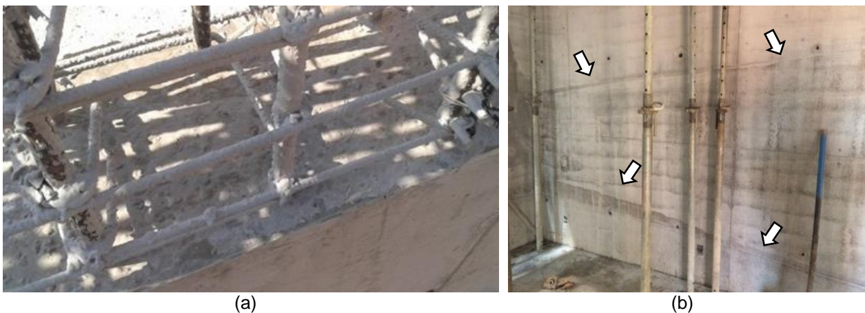
Figura 7 – (a) Exemplo de junta de construção sem tratamento adequado e (b) junta fria na parede decorrente de atraso na concretagem entre os diferentes caminhões betoneira (Arquivo Deseq, 2022)
