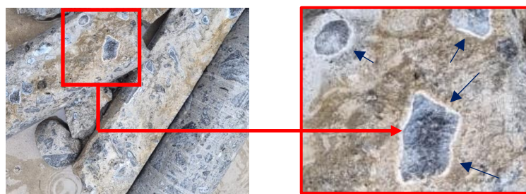
FIGURA 2 - Detalhe de testemunhos de concreto extraídos dos pilares do caso 1
