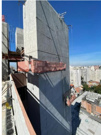
Figura 15 – Detalhe da etapa de tratamento do concreto (R.Yazbek, 2022)
