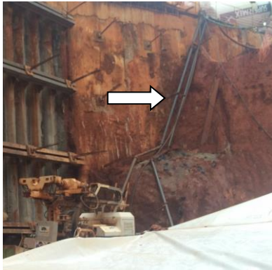
Figura 10 - Utilização de bomba para lançamento do concreto – Notar bomba reserva posicionada
