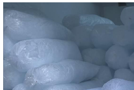
Figura 12 - (a) Adição do gelo para ajuste do espalhamento e temperatura do concreto; (b) armazenamento do gelo no caminhão frigorífico na obra
