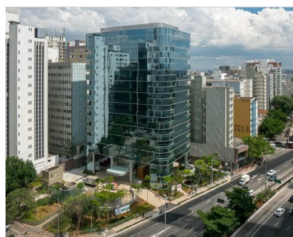
Figura 2 – Foto do edifício Grande Ufficiale Evaristo Comolatti
