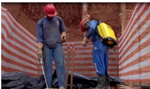
Figura 17 – Tratamento da junta utilizando o retardador de pega superficial do concreto
