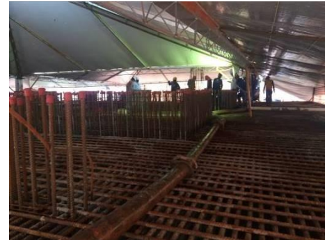
Figura 10 - Utilização de bomba para lançamento do concreto – Notar bomba reserva posicionada
