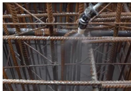
Figura 17 – Tratamento da junta utilizando o retardador de pega superficial do concreto
