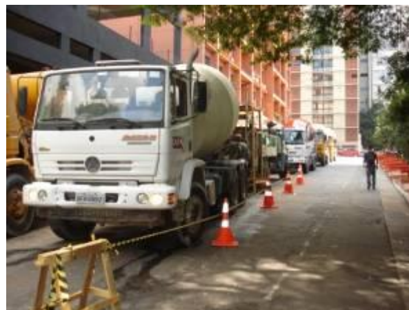
Figura 17. Posicionamento dos caminhões betoneira para fornecimento contínuo do concreto
