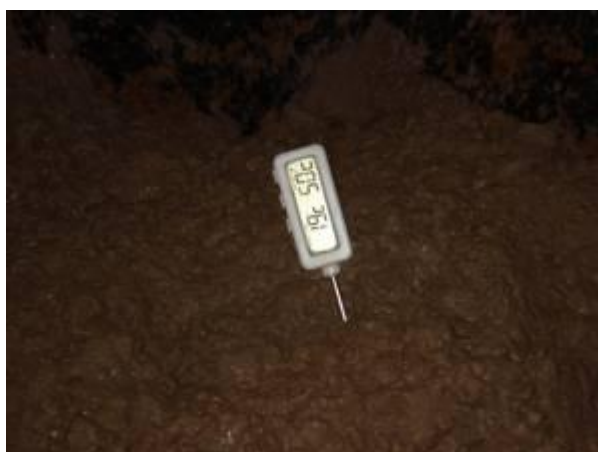
Figura 18. Termômetro de haste utilizado para medição da temperatura do concreto fresco previamente a concretagem
