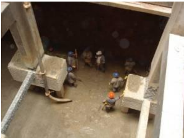
Figura 1. Concretagem da regularização do bloco de fundação
