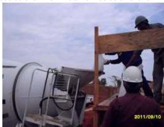
Figura 3 – Adição de gelo no caminhão betoneira no canteiro de obra
