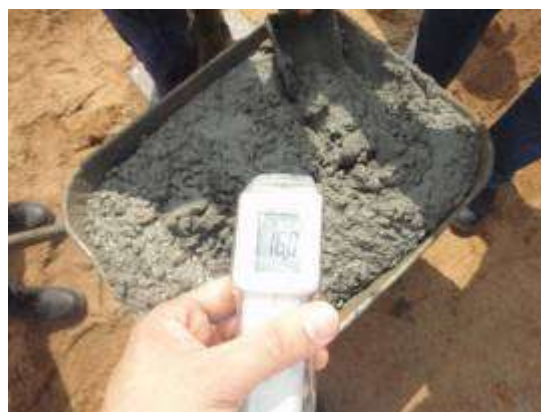
Figura 5 – Medição da temperatura de lançamento do concreto com termômetro digital – Temperatura indicando 16°C
