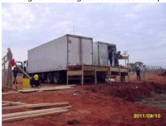
Figura 2 – Caminhões frigoríficos – Notar montagem das plataformas para adicionar gelo no canteiro de obra
