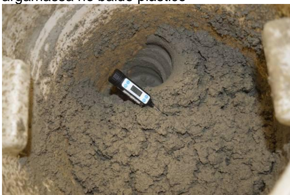
Foto 68 - Determinação da temperatura da argamassa no balde plástico
