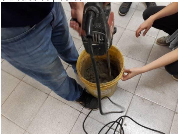
Foto 76 – Mistura dos materiais realizado em balde de plástico
