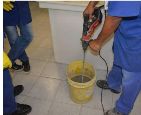
Foto 47 – Mistura da argamassa em balde de plástico
