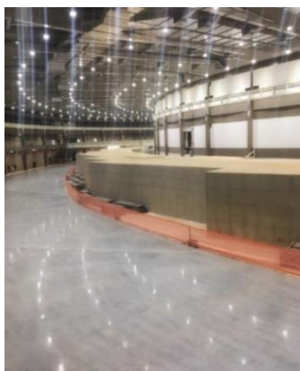
Figura 1 - Edifício Sirius – Maio 2018, figura 2: Piso especial destinados às linhas de luz na área de ensaios e túnel de blindagem. Arquivo pessoal: Xavier, L.S.
