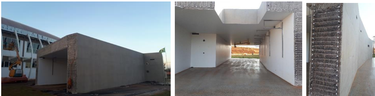
Figura 11 - Protótipo do túnel de blindagem e piso especial Tipo B, placa de 90cm.
