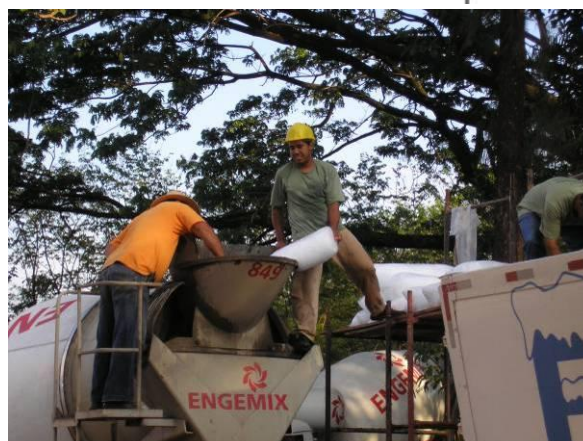
Figura 6 – Adição de gelo no caminhão betoneira
