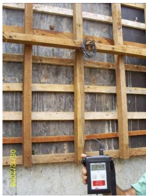
Figura 17 – Instalação de termopares no interior da estrutura
