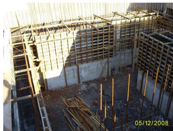
Figura 4 – Vista geral das formas para 3ª concretagem
