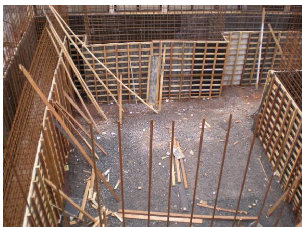
Figura 3 – Vista geral das formas para 1ª e 2ª concretagem
